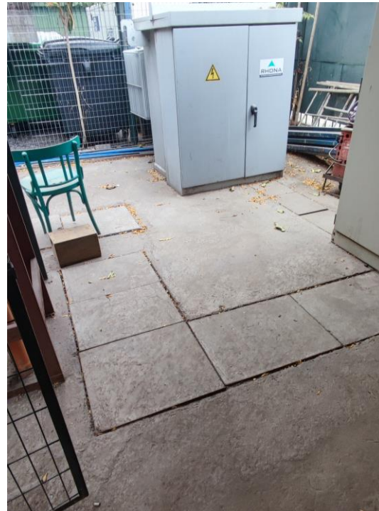
figura 5a: Tablero de distribución General Transformador N°2 figura 5b: Trinchera de cables área S/E Eléctrica
