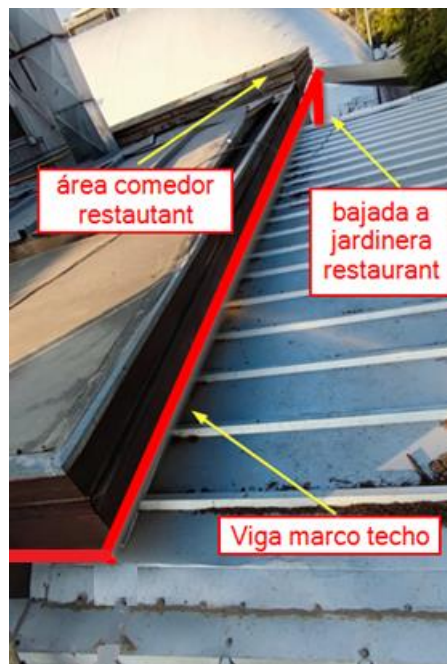
figura 12: Trazado canalización sobre área Cocina y comedor.
