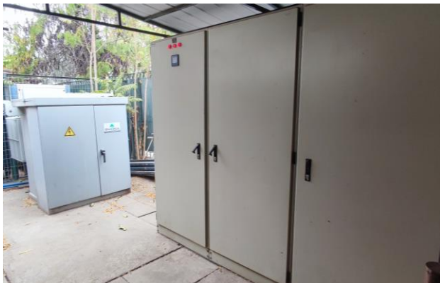
figura 5a: Tablero de distribución General Transformador N°2 figura 5b: Trinchera de cables área S/E Eléctrica
