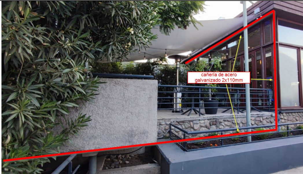
figura 13: Bajada de ductos en área comedor.
