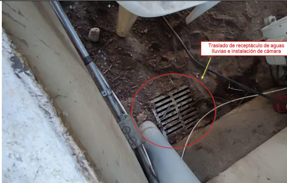
figura 14: Instalación de Cámara costado oficina restaurant.
