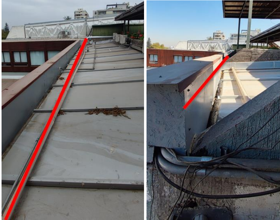
figura 9: Trazado canalización tras frontis Club Providencia.
