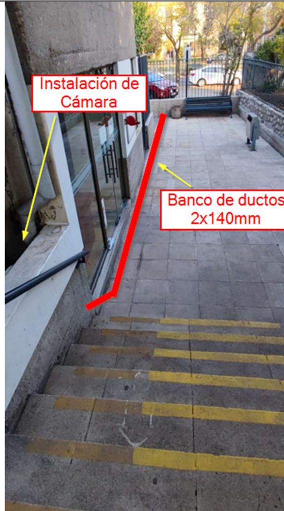
figura 15: Trazado de banco de ductos proyectado.
