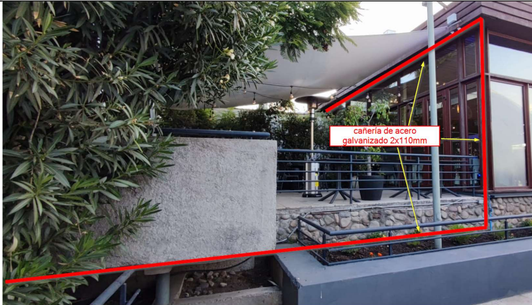
figura 13: Bajada de ductos en área comedor.
