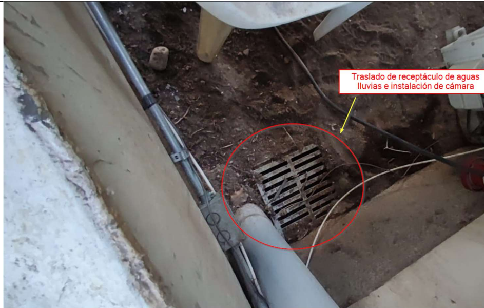
figura 14: Instalación de Cámara costado oficina restaurant.
