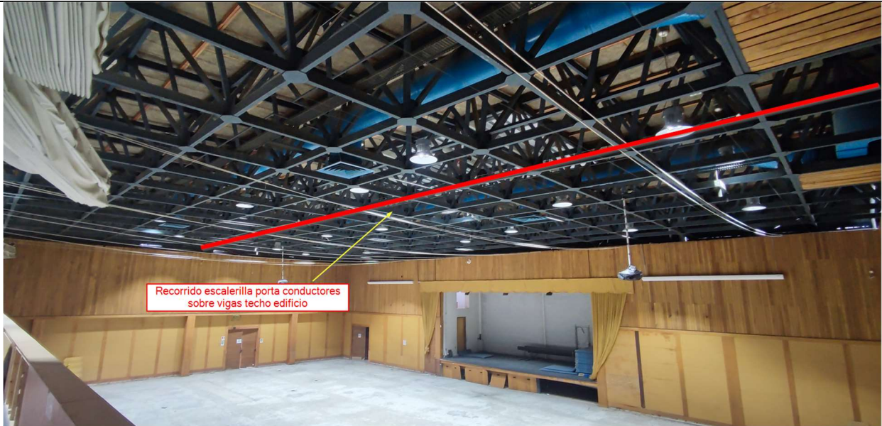
figura 8: Trazado canalización sobre vigas soporte techo edificio multi cancha
